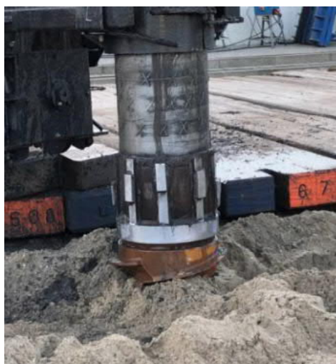
Figuur 3-4: Schroefpunt grondverdringende schroefpalen
