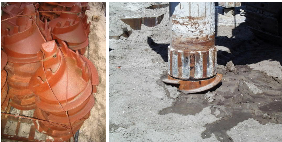
Figuur 4.3: Conische vorm van de paalpunt
